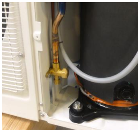
Figuur 2: Onderhoudsventiel in de vloeistofleiding
