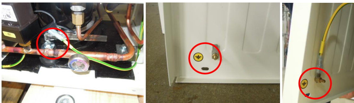
Figuur 10: Details van de aarddraad bevestigingen
