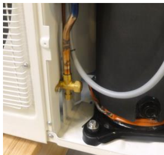
Figuur 27: Schraeder aansluiting in de vloeistofleiding
