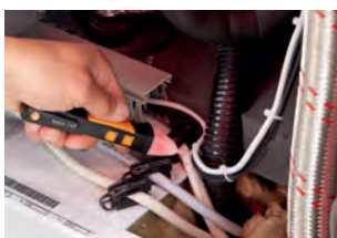
Eerste proef van voedingsspanning aan een compressor.
