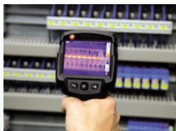
Elektrische installaties controleren
