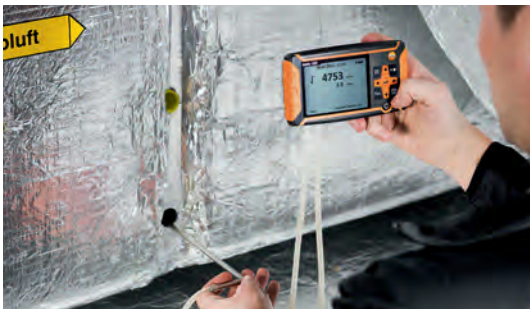
Drukverschil/pitotbuismeting.
